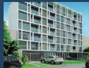
Edificio Roma Miraflores
